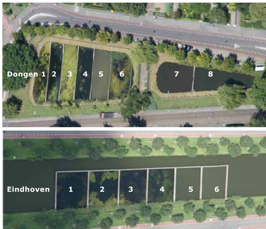
FIGUUR 12 LUCHTFOTO'S (19 AUGUSTUS 2011) VAN DE COMPARTIMENTEN IN DE VIJVERS TE DONGEN (BOVEN) EN EINDHOVEN (ONDER), WAARBIJ DE CIJFERS OVEREENKOMEN MET DE HIERBOVEN AANGEDUIDE OMSCHRIJVING VAN UITGEVOERDE MAATREGELEN PER COMPARTIMENT
